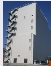
大型休憩所外観
