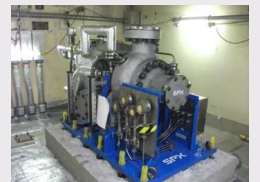
高圧代替注水系（注水機能強化）設置工事
